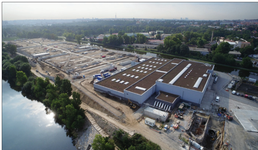
Obr. 1. Letecký pohled na Novou vodní linku ÚČOV Praha
