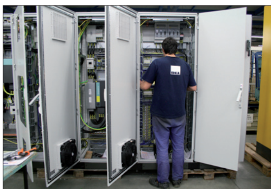
Obr. 2. Montáž rozváděče řídicího systému a pohonů
